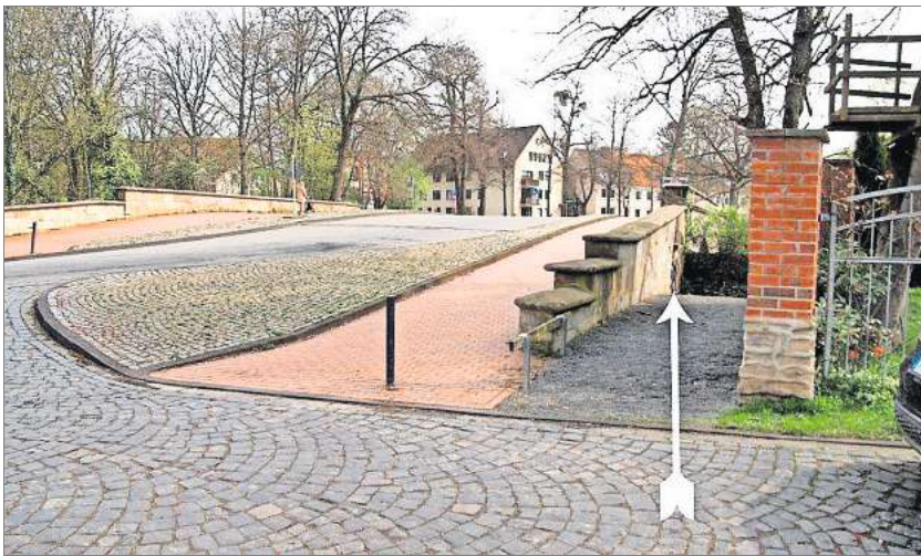
Der Pfeil zeigt den Weg zu der ehemaligen Toranlage. Rechts das Privatgrundstück. Auf der Brücke ist die Fallöffnung noch deutlich zu sehen.
